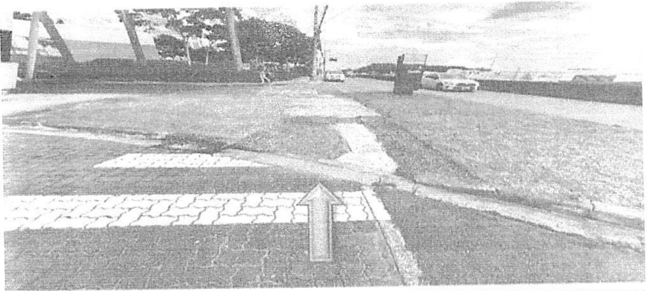
Fig. 1 - Piso tátil de guia na calçada externa para acesso a portaria
